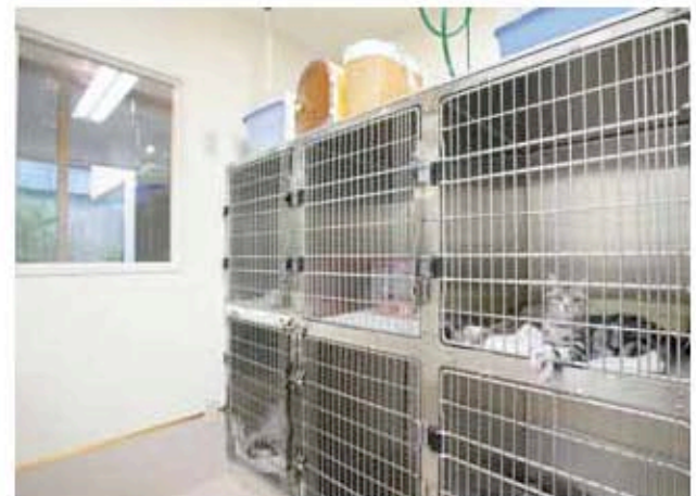
上から：各診察室へと通じる処置室。これから機材を充実させていく予定／中の様子がすぐわかるように大きめの窓にした入浴室。
